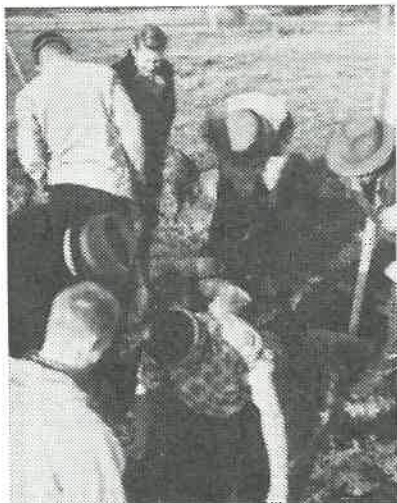
Ved inntaket til brønnen.
