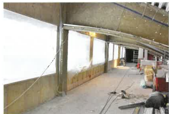
Innredningen av fjerde etasje pågår for fullt
